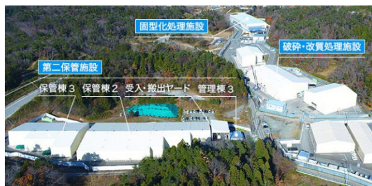
第二保管施設 破砕・改質処理施設
