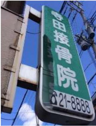
シートの発注、取り外し、全体のさび落とし、取り付け台のペンキ塗り、配線移動、アクリル板カット、シートの貼り付け、本体の再度取り付け、蛍光灯の交換、シートを貼ったアクリル板の挿入、ふたと支持棒の固定といった工程でした。
