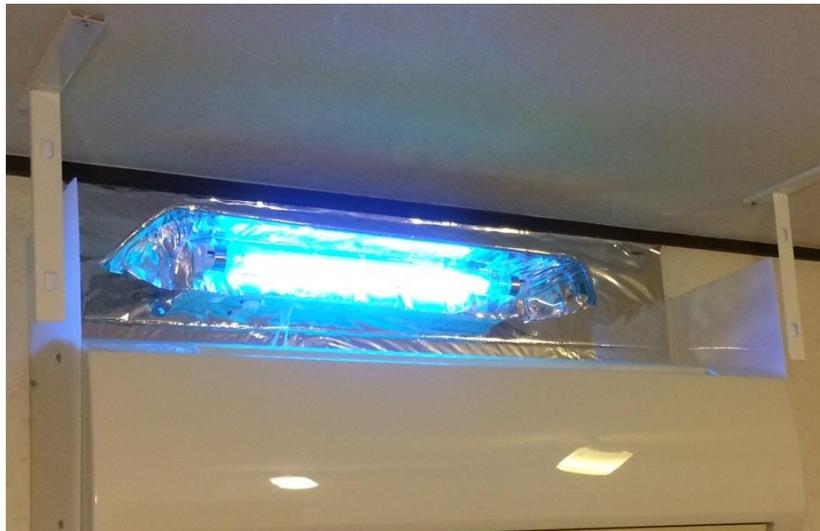
**前面アクリル板をはずした内部の様子** 壁にアルミシートを貼り付け、アルミ板で天井への紫外線を遮光。アクリル板と天井との間から吸気され、エアコンに入るまでに空気が除菌される。
